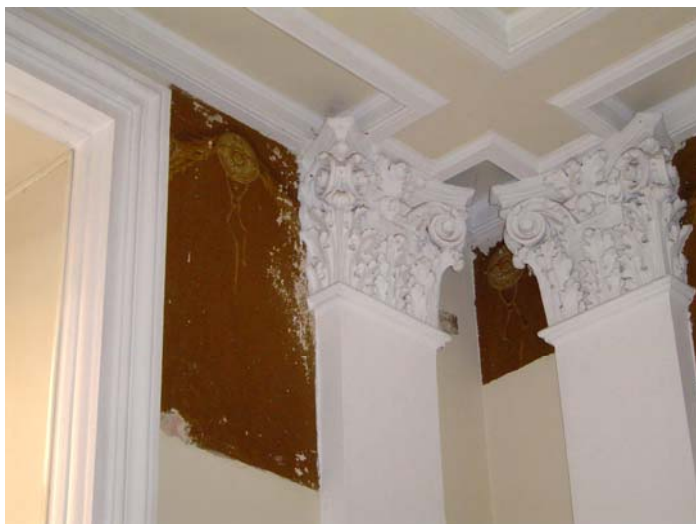
Figura 30 – Detalhe da pintura do hall da residência com os capitéis das colunas.
