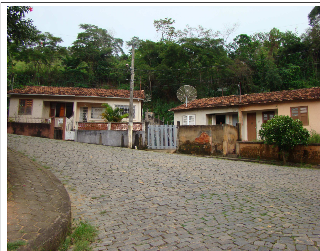
Figura 20 – Dois conjuntos de casas geminadas da Rua Dr. Homero Monteiro de Barros (Morro dos Cabritos). As poucas que se mantêm originais das cinquenta construídas
