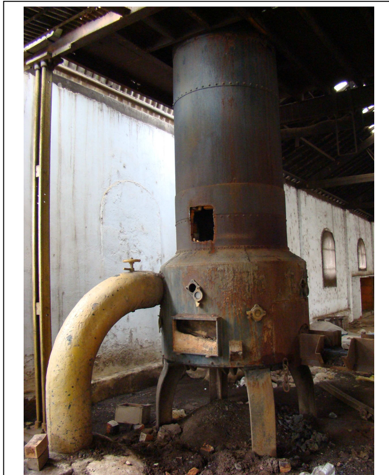
Figura 17. Alto forno da fundição da Oficina, com capacidade para sete toneladas.
