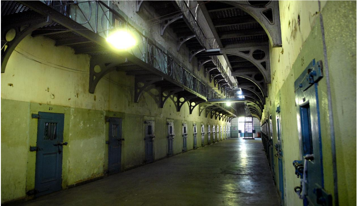
Figura 10 – Instituto Penal Vieira Ferreira Neto, possui ventilação privilegiada e é a unidade prisional do Estado do Rio de Janeiro mais adequada para os presos idosos. O prédio encontra-se tombado pelo Patrimônio Histórico Municipal de Niterói. Foto de setembro de 2011 - de Renzo Gostoli.
