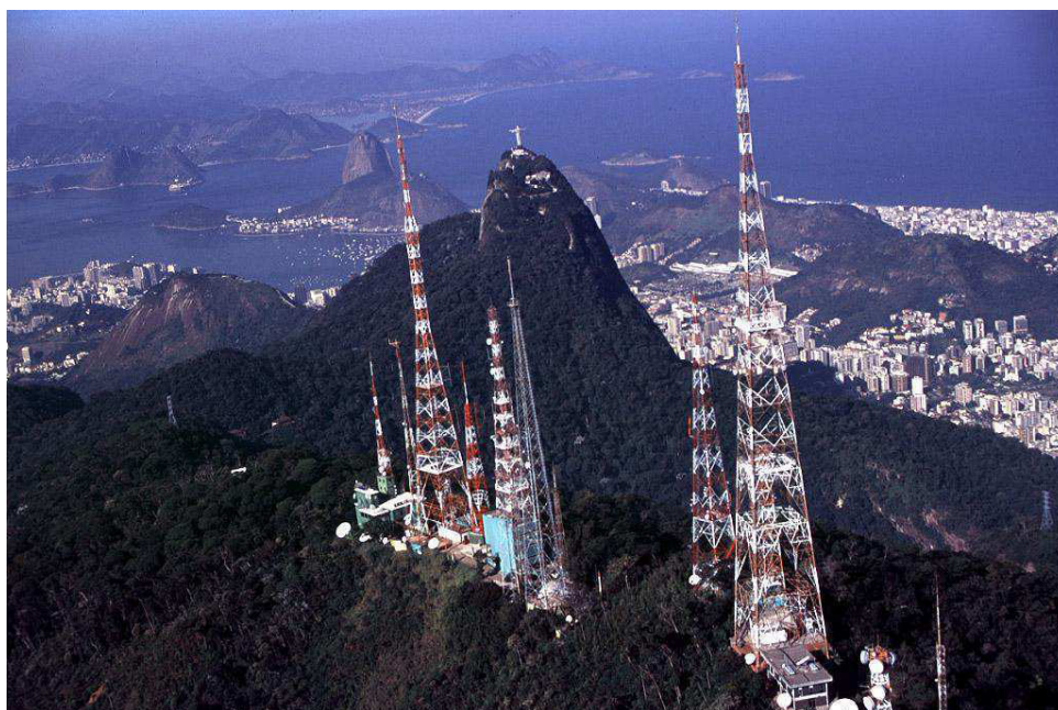
Figura 12 - Posicionamento das antenas e torres na área interna do Parque Nacional da Tijuca, morro do Sumaré.
