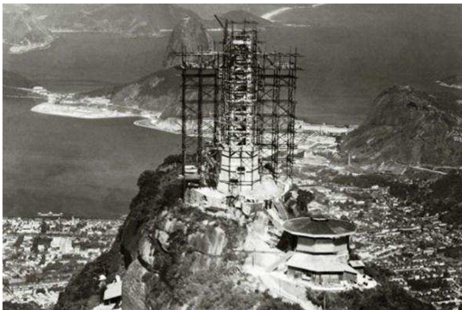
Figura 09 - Vista aérea da obra do Cristo, junho de 1930.
