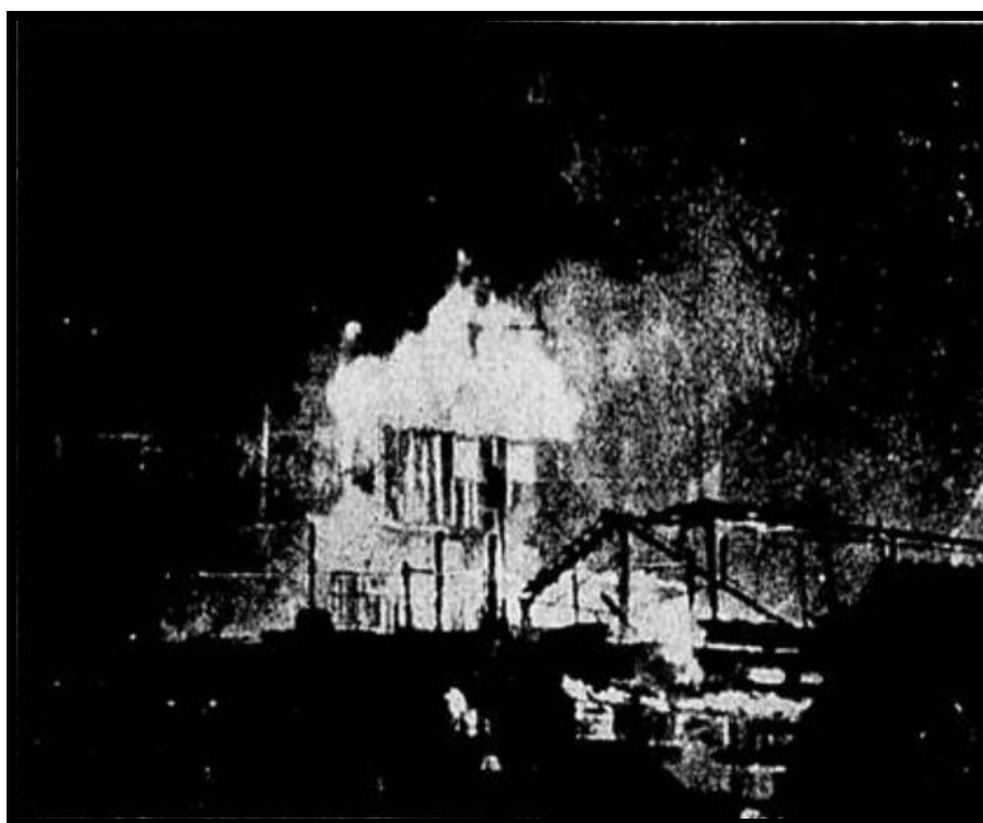
Figura XXVI: Outra foto do incêndio do Pasmado, aparecida no Correio da Manhã em 25/01/1964. (p. 3), junto à matéria “Fim do pasmado”.
