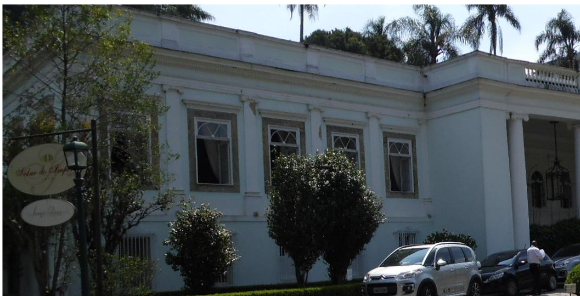
Figura 19: Fachada com pontos desgastados. Fonte: Acervo Pessoal.
