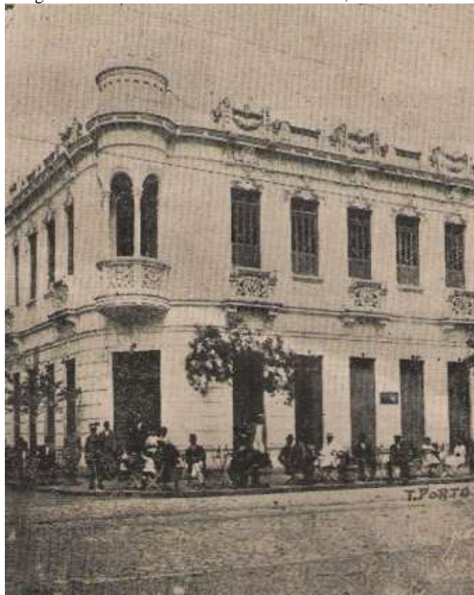
Imagem 22 – Prédio da lanchonete “O caldo”, em 1900
