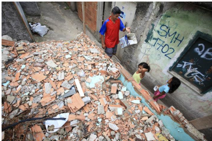
Figura 22: Escombros e casas marcadas no Morro da Providência.
