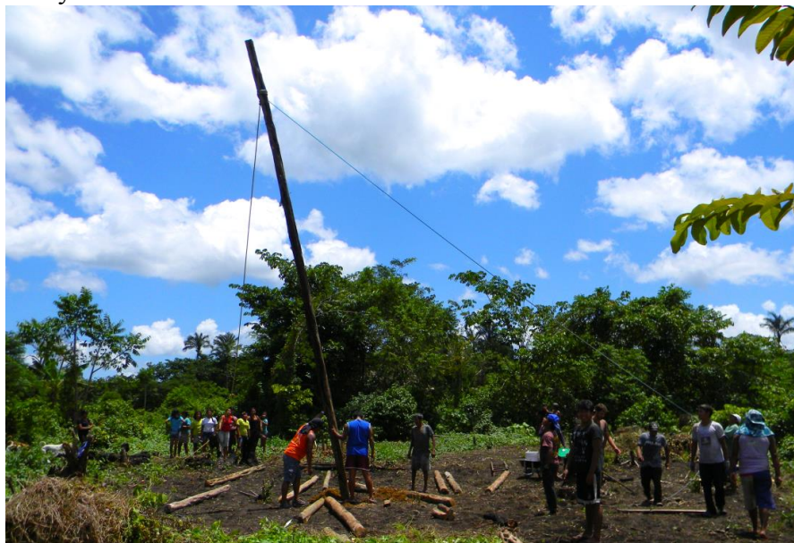
Foto 33 – Todos auxiliam na colocação esteio central na construção da tamiriki “modelo kaxuyana”
