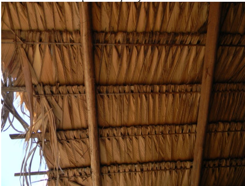
Foto 27 – Detalhe da palha trançada já no telhado
