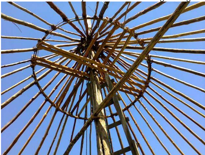
Foto 41 – Detalhe da terça intermediária e das vigas ortogonais superiores ( kamayura )
